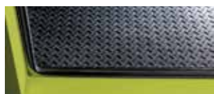
Металлический пол контейнера с рифленной поверхностью
